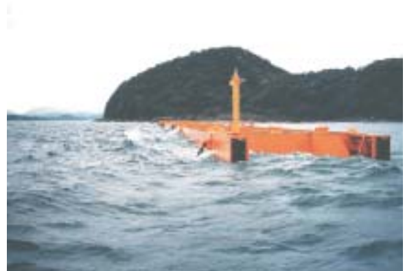
Photo. 7 補修完了後の設置状況
